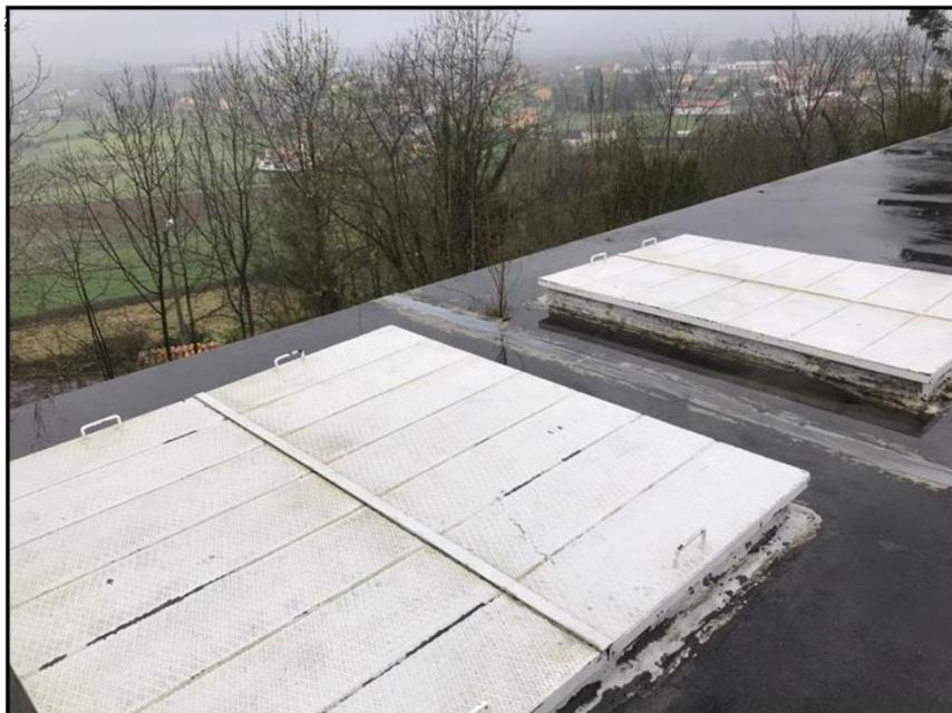
Por otro lado, las juntas de construcción-dilatación de la cubierta presentan un estado de conservación totalmente inadecuado con excesiva luz entre juntas y cubierta y con importantes deterioros en la propia junta que tampoco ofrece la mínima garantía de estanqueidad que evite la entrada de agua al interior del depósito.
