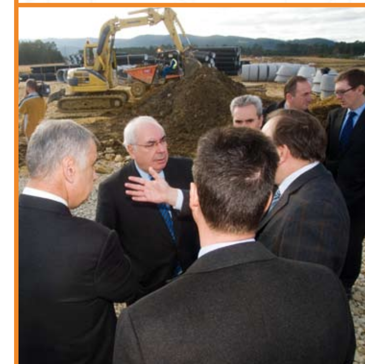
El Presidente del Principado y el Alcalde de Castropol visitaron las obras de urbanización.
