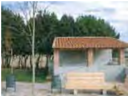
Proyecto de recuperación del lavadero y adecuación de la zona verde.
