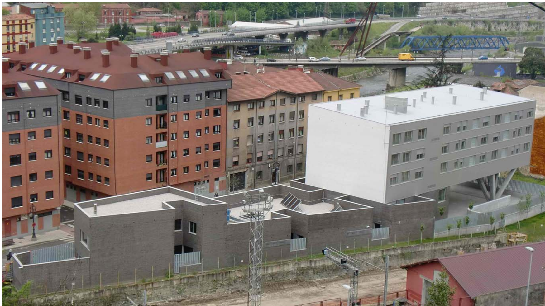
Casa Cuartel de Langreo, obra terminada en diciembre de 2010.
